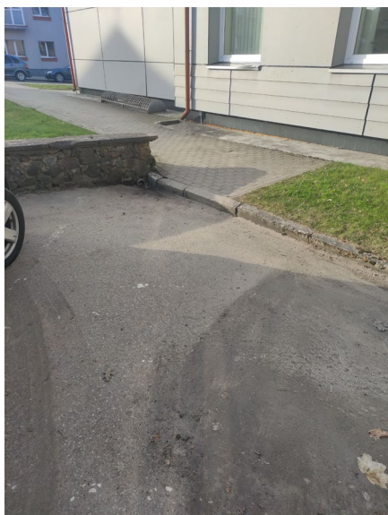
Pav. 4 Paviršinių nuotekų surinkimo „vamdžis“ nueinantis į niekur.
