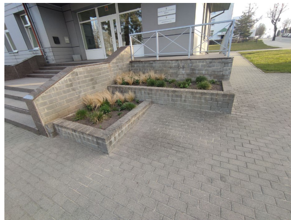
Pav. 3. Betoninių trinkelio pėsčiųjų takų paviršių nuolydžiai deformuoti dėl neįrengtos/netinkamai įrengtos/plaunamos dangos konstrukcijos; iš atraminių sienų suformuotų iš betoninių trinkelio plaunamos druskos, nuvarvėjimai per siūles gadina vietos estetinį vaizdą
